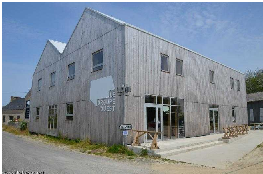
Façade principale avec entrée - © ATB / © F. Sabatier
